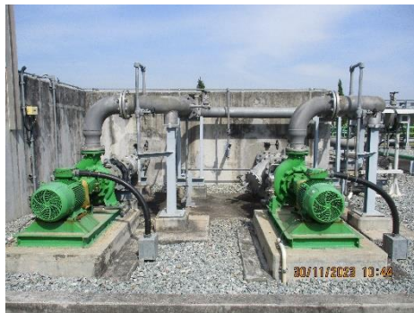
ภาพที่ 2.2-8 ฐานคอนกรีตลดแรงสั่นสะเทือน
