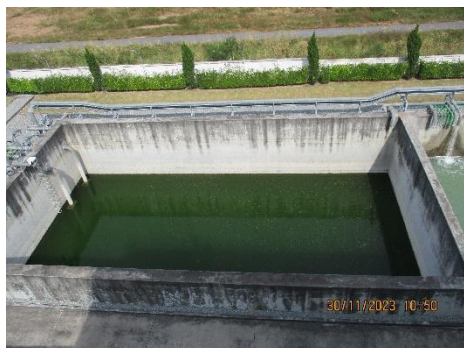
ภาพที่ 2.2-14 บ่อพักน้ำทิ้งฉุกเฉิน (Emergency Pit)
